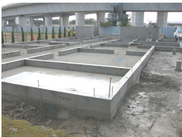
平成27年11月26日 基礎工事
