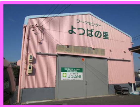
外壁断熱塗装整備
